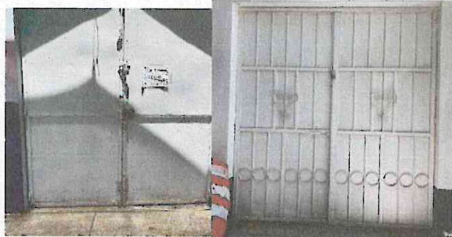
Foto 4: MANTENIMIENTO DE PORTONES DE METAL
