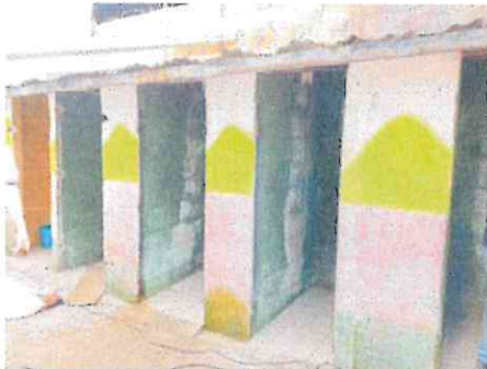
Foto 1: SUSTITUCION DE SANITARIOS
