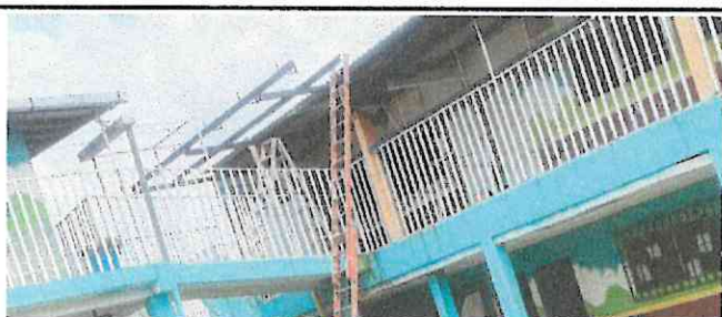
Foto 5: MANTENIMIENTO A BARANDALES DE METAL EN PASILLOS
