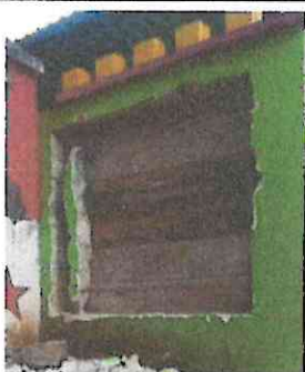
Foto 3: REPARACION DE MURO PERIMETRAL
