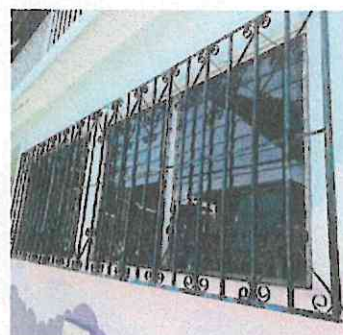
Foto 6: MANTENIMIENTO DE BALCONES
