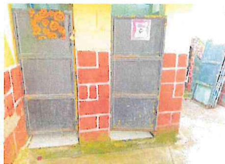
Foto 2: MANTENIMIENTO DE PUERTAS
